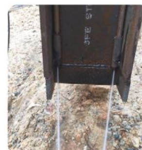
4 MPa x 40ℓ/分程度の 低圧&少量の水を使用します
